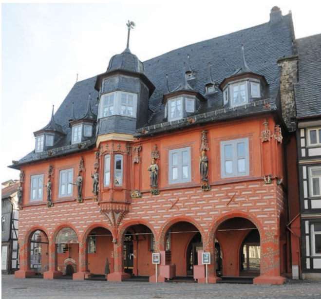
Kaiserworth, an der Gebäudeecke im Nordwesten fehlen die Nischenausschmückungen (Fotos: Piegsa)
